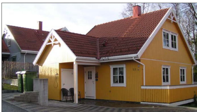
Fig. 89: Bilde av husrekke, Slynga og enkelthus, Buholen
