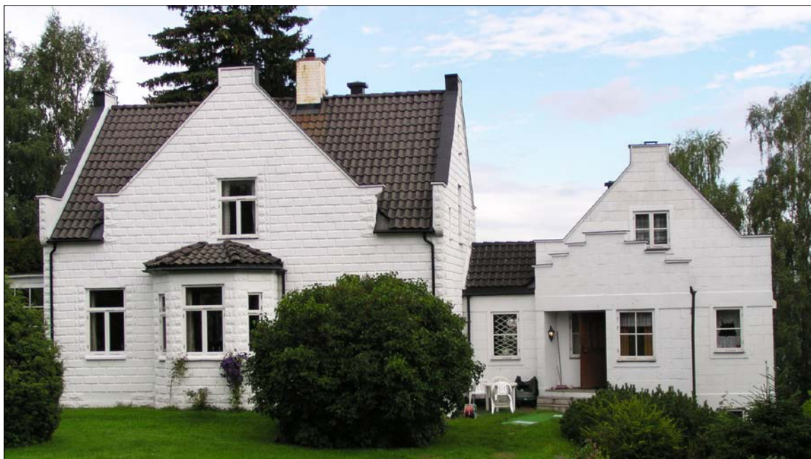
Fig. 47: Dette huset i Gamle Strømsveg har fått tilbygg via et mellombygg. Volumer og proporsjoner er beholdt.
