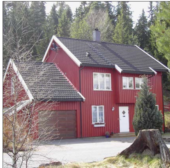
Fig. 92: Enkelthus i rundkjøringen
