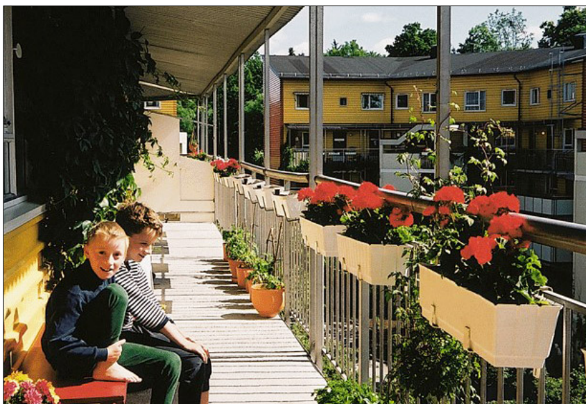
Fig. 44: Svalganger bør gi atkomst til et begrenset antall boliger. Svalgangeren kan brukes som en ekstra balkong og en halvprivat sone, et sted for uformell sosial kontakt. Her går mange leiligheter over to etasjer, slik at det er svalgang bare for annenhver etasje. Dermed er det fortsatt god kontakt mellom boligene og tunet, og svalgangene er ikke så dominerende. Casinetto borettslag i Oslo, arkitekt: Telje- Torp og Aasen Arkitektkontor
