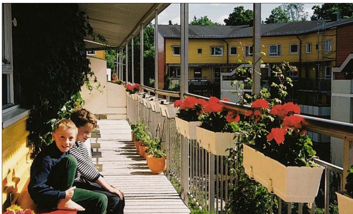
Fig. 149: Casinetto borettslag i Oslo - Telje- Torp og Aasen Arkitektkontor. Svalganger bør gi atkomst til et begrenset antall boliger. Svalgangen kan brukes som en ekstra balkong og en halvprivat sone, et sted for uformell sosial kontakt. Her går mange leiligheter over to etasjer, slik at det er svalgang bare for annenhver etasje. Dermed er det fortsatt god kontakt mellom boligene og tunet, og svalgangene er ikke så dominerende.
