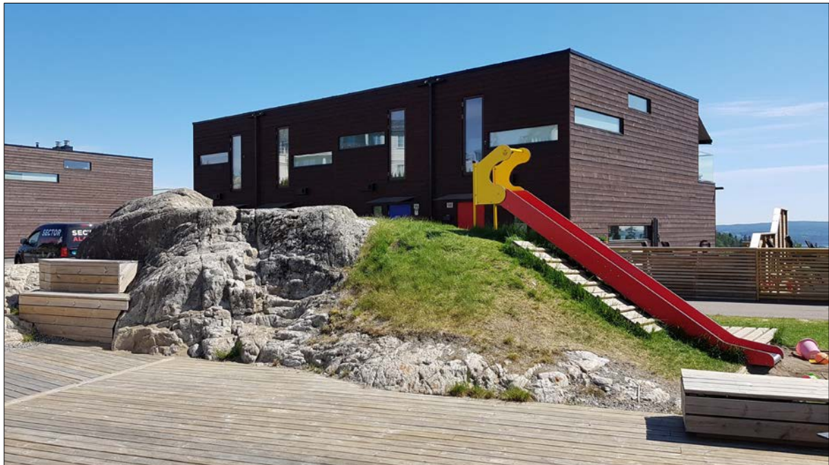
Fig. 113: Bilde fra lekeklassen på område K4, Hektneråsen. Eksisterende vegetasjon og terreng er bevart og benyttes som uteareal.
