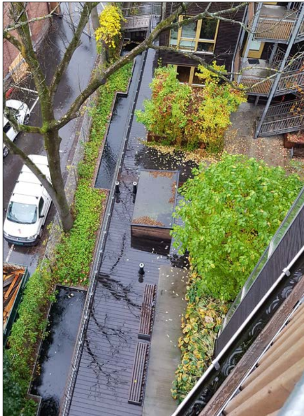
Fig. 123: Takvann ledes i åpne renner i bakgården og ender opp i større åpne magasiner. Takvannet blir i dette prosjektet utnyttet til å ha en estetisk kvalitet for bomiljøet, samt at overvannet håndteres lokalt. (Christian Krohgs gate 39-41, prosjekt av Dronninga Landskap).
