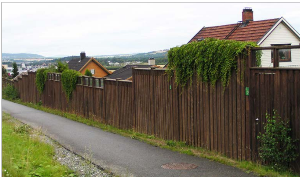
Fig. 104: Foto av støyskjerm ved Åmot. Støyskjermeren er gitt et variert uttrykk ved at den er trappet, og ved at det er enkelte transparente felter som gir lys og utsikt for bebyggelsen bak. Vegetasjon er med på å gi liv og variasjon til støy-skjermen
