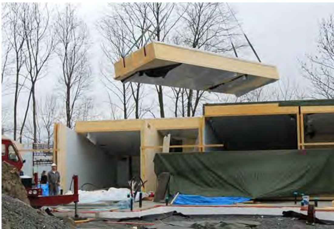
Figur 2-2: Utbygging av Fjell Barnehage: Massivtreelementer er brukt til å skape et robust og presist sandwich-byggesystem med stor grad av prefabrikasjon. Kilde: arkitektur.no
