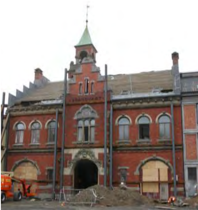
Figur 4-4: Integrering av verneverdige fasader har vært en utfordring.
