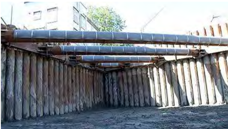
Figur 4-9: Rørspunt sikrer byggegropa i utløpet av Strindheimtunnelen.
